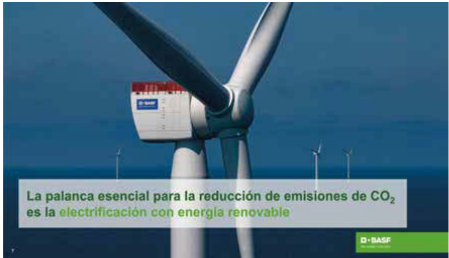
Figura 2.7 Aerogenerador de BASF
