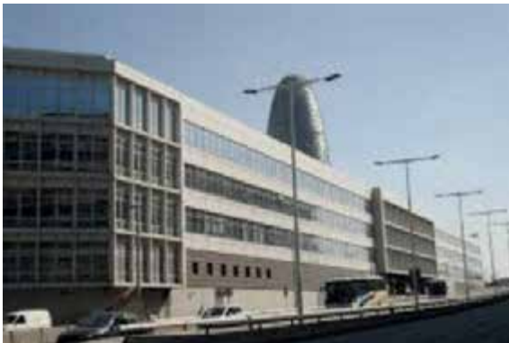
Pie de foto: El edificio de los talleres de la Hispano Olivetti de Barcelona en la actualidad.
